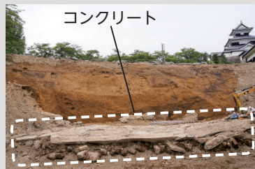
石垣裏側のコンクリート
