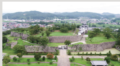
災害復旧が完了した小峰城
