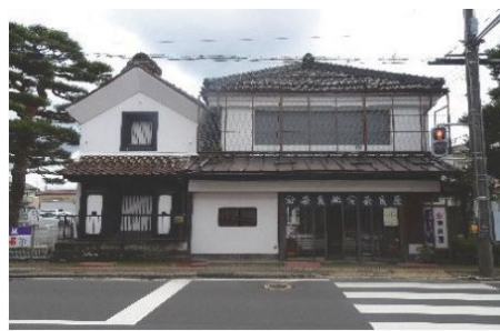
奈良屋呉服店建造物群
