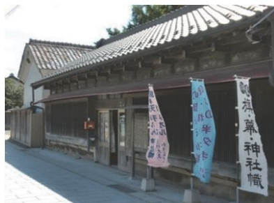
本家富川屋染物店建造物群
