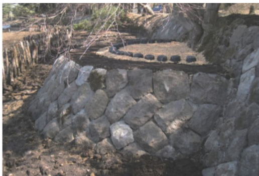
史跡及び名勝南湖公園の護岸整備
