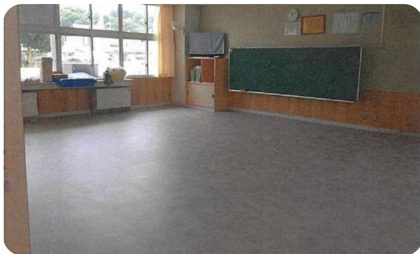
白河第三小学校床改修工事（施工後）
