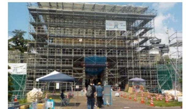
8月24日、復元工事が進む小峰城清水門の工事現場の一般公開が行われ、380人ほどが訪れました。公開時は、門本体の骨組みを作る工事が終わり、屋根の下地作業がほぼ完了した状態で、来場者は建築中しか見ることのできない内部の様子を熱心に見学していました。
