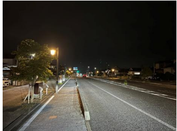
国道 294 号白河バイパス 歩道を照らす背の低い照明が整備されている
