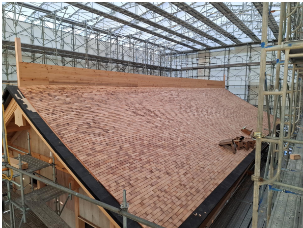
▲写真 令和7年10月6日現在 土居葺き完了
