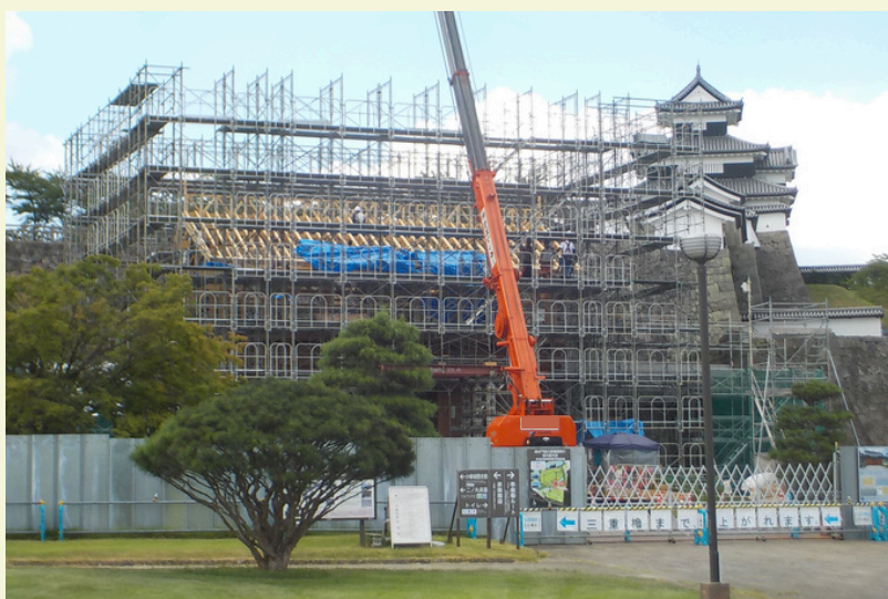
▲清水門本体の工事の様子
