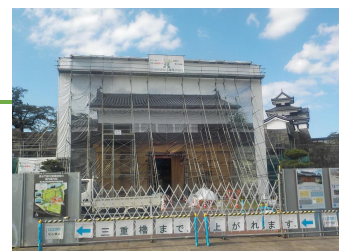
復元中の清水門
