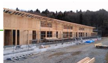
建築工事の様子
