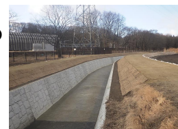
改修した護岸
