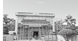
復元中の清水門
