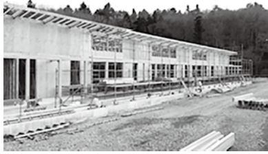
建築工事の様子
