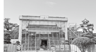
復元中の清水門
