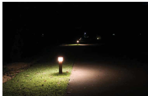
整備が完了した園路照明 (ポラード照明)
