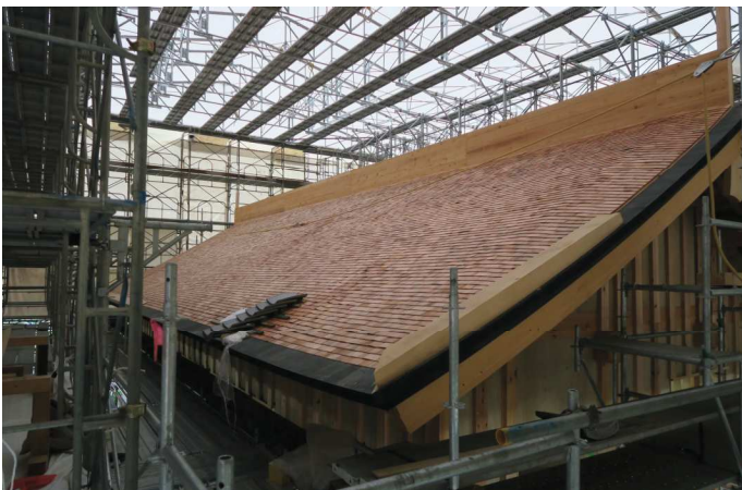
【瓦を葺く前の屋根】
