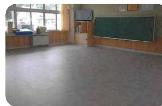
白河第三小学校床改修工事施工後
