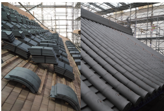
野地板上に仮置きされた平瓦（左）と葺かれた屋根（右）
