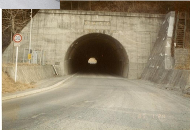
舎利石トンネル
