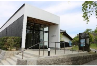
【増築部分外観】
