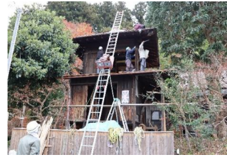
【解体工事施工状況】
