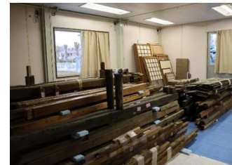
【解体部材保管状況】
